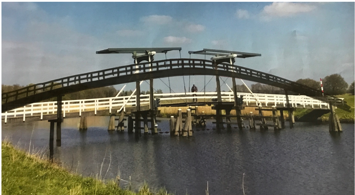
Afbeelding 1 Nieuwe brug geprojecteerd over de bestaande ophaalbrug
